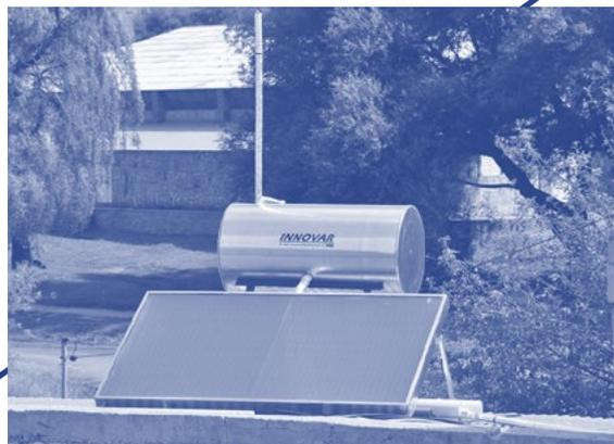
envases de tetrabrik. Estos sistemas comúnmente se diseñan para cubrir entre un 70% y 80% del consumo anual de agua caliente y suelen complementarse con un equipo de apoyo que puede ser un termotanque convencional o una resistencia eléctrica. Por lo tanto, se logra ahorrar hasta un 80% del gas o la electricidad que se utiliza para el calentamiento de agua. Y, además del ahorro económico, se evita ese mismo porcentaje de emisiones de gases de efecto invernadero.
